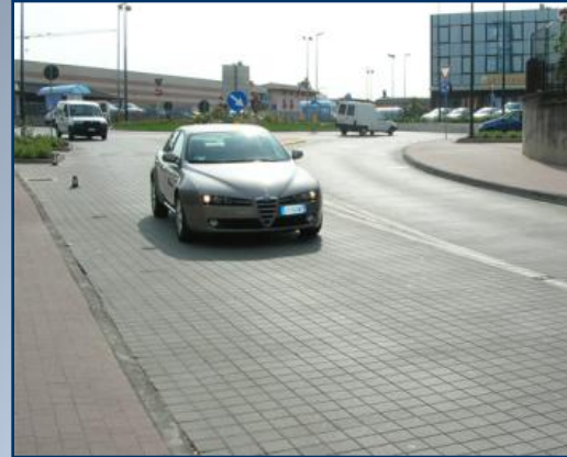
Roundabout – Palazzolo sull'Oglio (BS)
